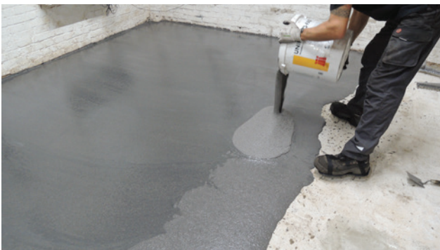
Käytännön esimerkki Juoksevan tasoitekerroksen asentaminen betonille
