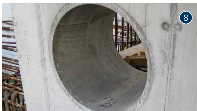
FZR400/300 asennettuna vedenkäsittelylaitokseen,
