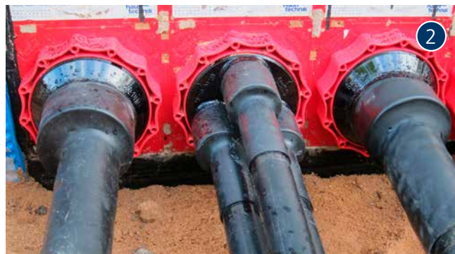
järjestelmäsuoja HSI150 D1 ja D3 – kuuma supistusmenetelmä
