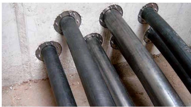
HRD puristustiivisteitä asennettuna
