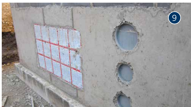
ZVR150 ja ZVR200 valettuina seinään HSI150 viereen 3x5 pakettia
