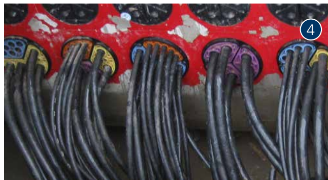
seinäinsertti HSI150 S3 SEG-segmentillä
