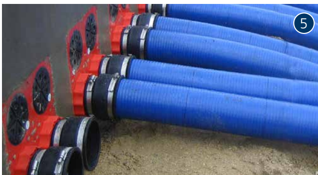
järjestelmäsuoja KES MA150 D, mitä käytetään yhdistämään Hatflex 14150 seinäinserttiin HSI150
