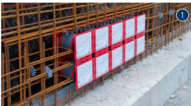
kaksoisseinäinsertti HSI150 K2 ennen betonointia
