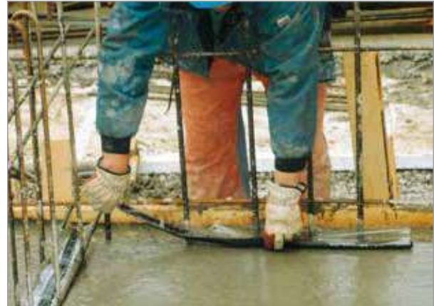
Synkoflex® asennus tuoreeseen betoniin
