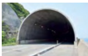
Tunnelit ja betoniputket
